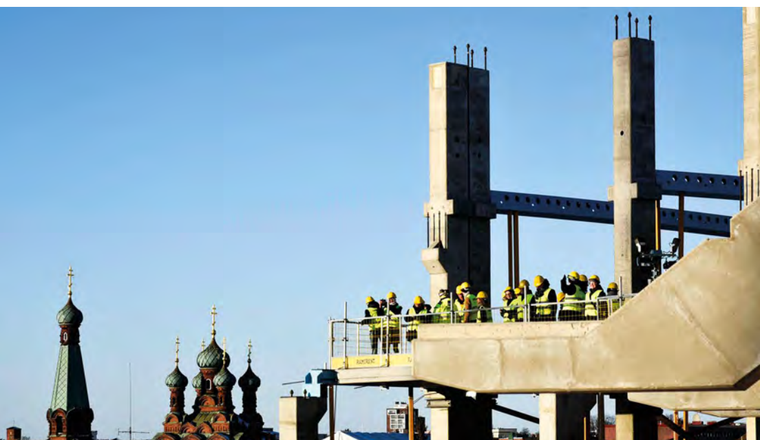
Yläkuvassa opetusalan vaikuttajia tutustumassa rakennustyömaahan Tampereella syyskuussa 2017. Alemmassa kuvassa opinto-ohjaajia, jotka vierailivat SRV:n Tampereeseen kansi ja areena -työmaalla vuonna 2020.
