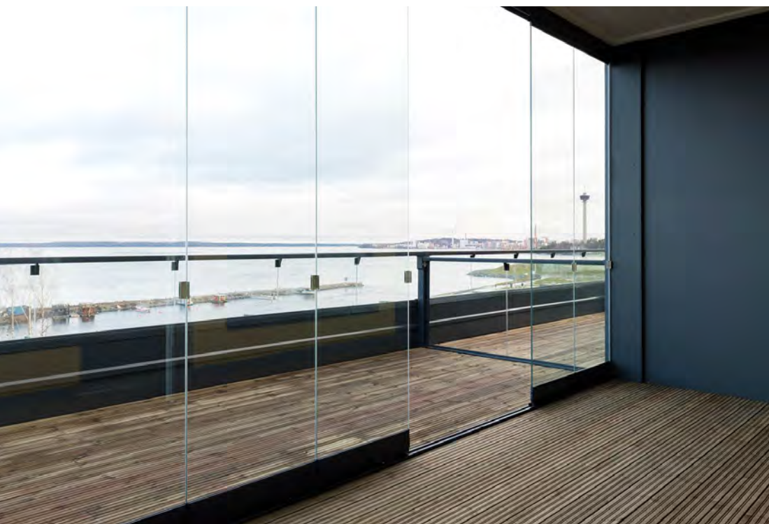
Pohjola Rakennuksen kohde Pisparannan Arielle valmistui vuoden 2019 lopulla Tampereen Santalahteen.
