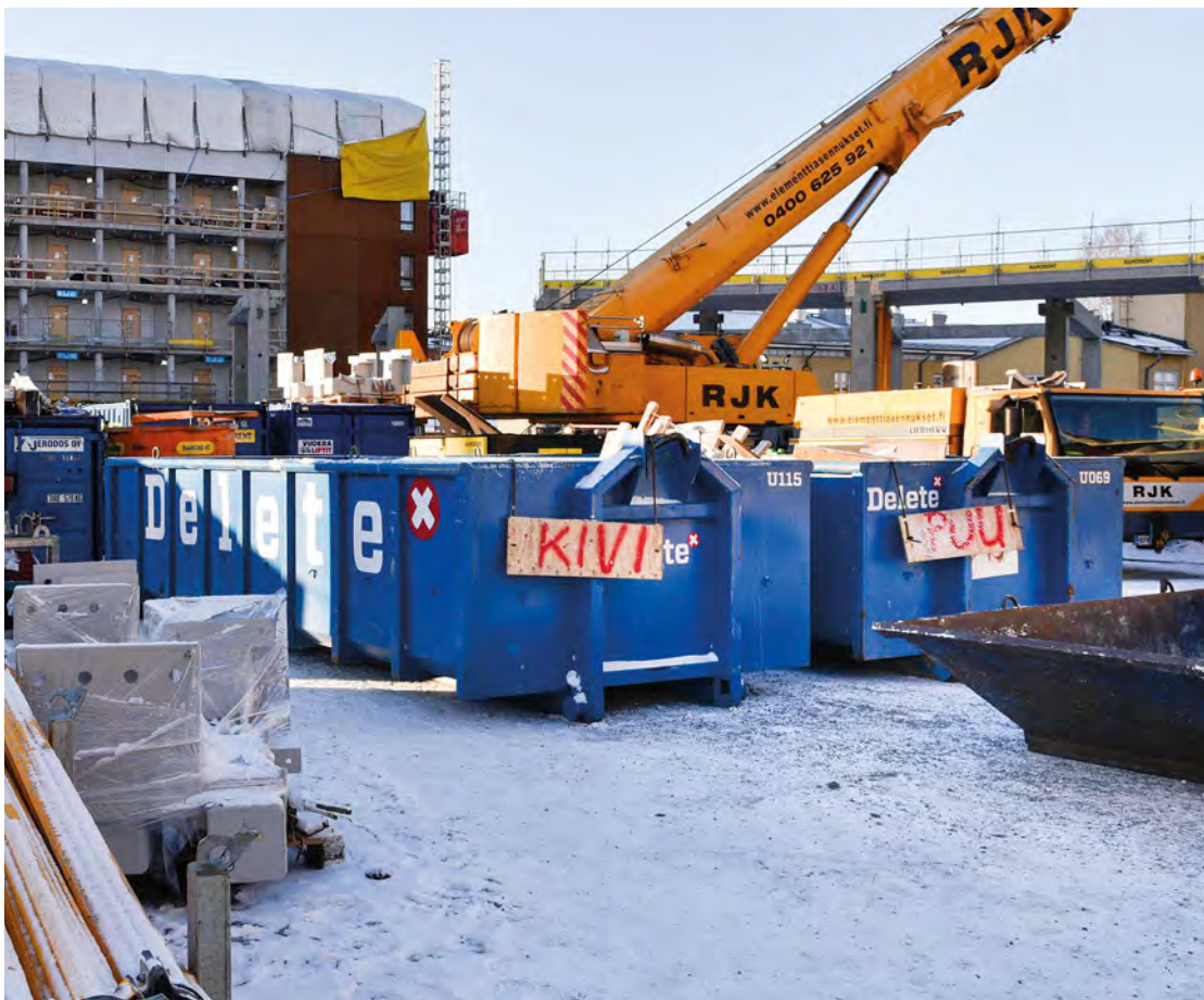
SRV:n työmaa Tampereen kansi ja areena vuonna 2020.
