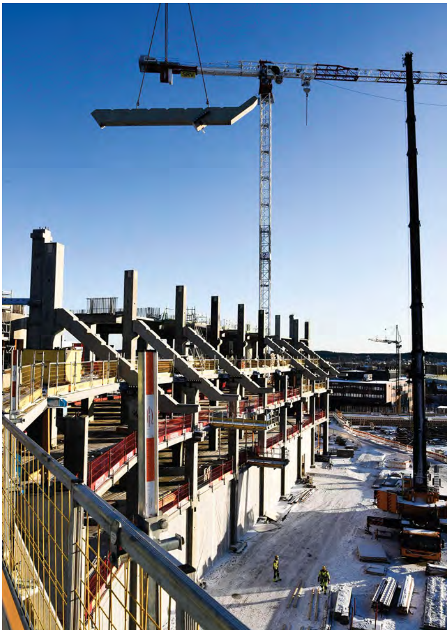
SRV:n Tampereen kansi ja areena -työmaa vuonna 2020.
