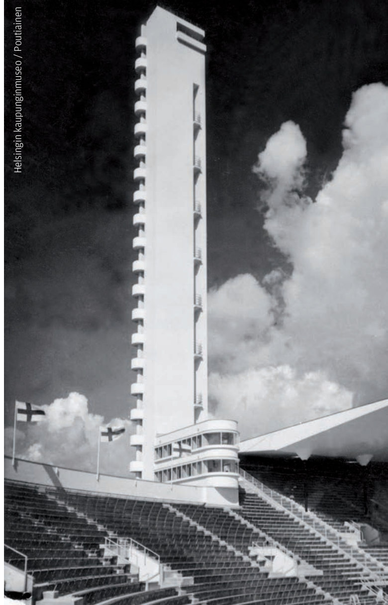
Stadionin tornin rakentaminen sujui turvallisesti siihen nähden, että säädökset olivat nykynäkökulmasta kehittymättömät.
