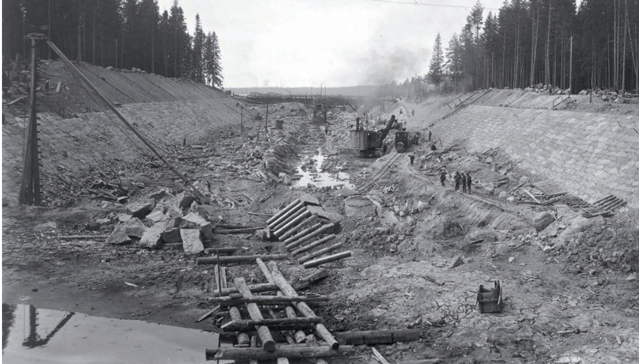
Kaivinkone lastaa maansiirtovaunuja Lavolan avokanavan työmaalla Saimaan kanavalla.
