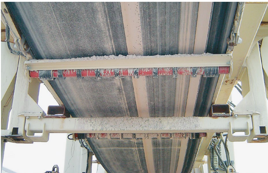
KUVA 9. Kuljettimen alapuolisissa kannatinrullissa on sormisuojaat paikoillaan → kaksi oikein-havaintoa.
