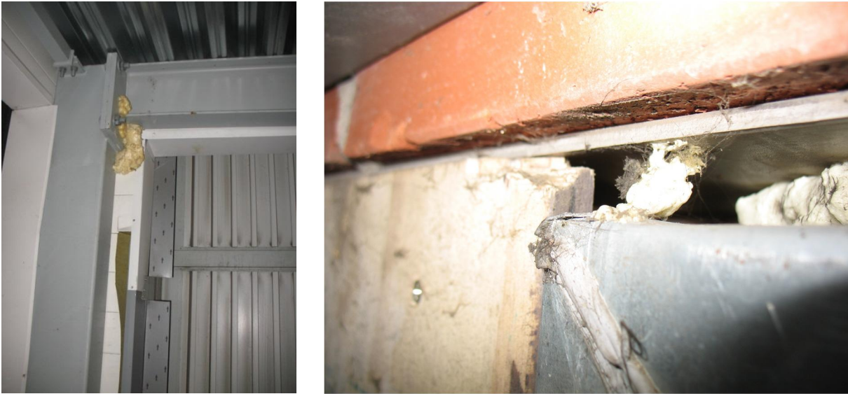
Kuva 13. Ulkoilmakammiot eivät useinkaan vastaa materiaaleistaan, puhtaudeltaan, puhdistettavuudeltaan tai tiiviydeltään ilmanvaihtojärjestelmälle asetettuja vaatimuksia.
