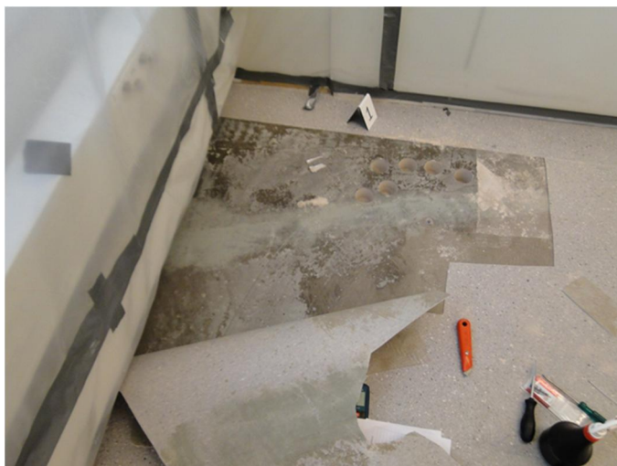
Kuva 8. Rakennusmateriaalien päästöjä alettiin tutkia 70-luvulla jolloin lastulevyjen liima-aine ureaformaldehydihartsit hajosi kosteuden vaikutuksesta. Nykyisin emissio-ongelmat on liitetty pääasiassa muovimattopinnoitteiseen lattiarakenteeseen.
