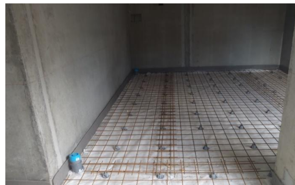
Kuva 3. Maanvarainen betonilaatta valetaan perusmuuria tai kantavia seinärakenteita vasten ilman erikseen suunniteltua tiivistämistä (esim. bitumikermiä)
