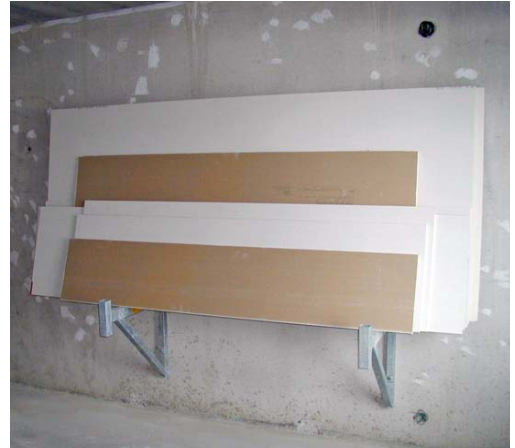
Kuva 30 Levyt on nostettu seinälle lattian kuivumisen ajaksi. Lattia pääsee kuivumaan ja levyt eivät vaurioidu.
