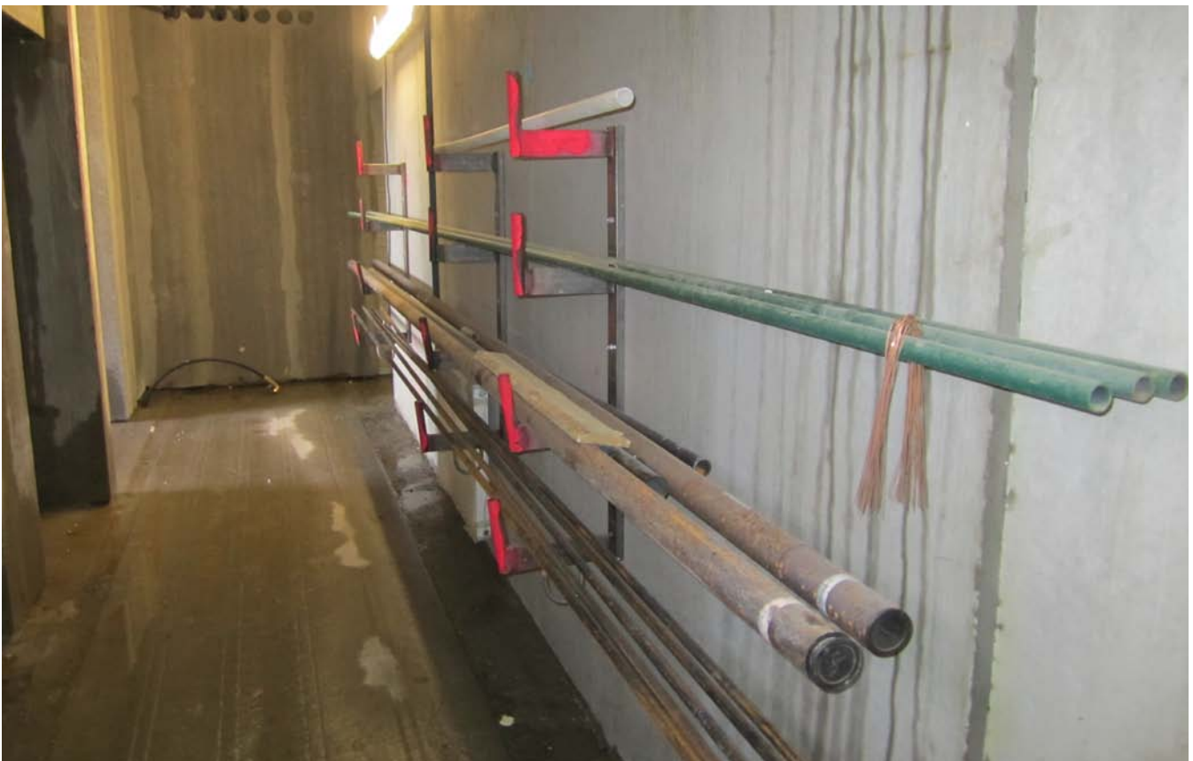
Kuva 29 Putket varastoituna putkifakissa. Kulkureitti säilyy siistinä ja vapaana. Varastointiteline on maalattu huomioväriellä, jotta sitä osataan varoa.
