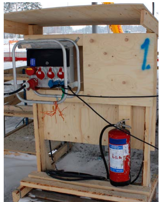
Kuva 28 Esimerkkejä sähkön vetämiseksi työmaalle rakentamisen ajaksi.
