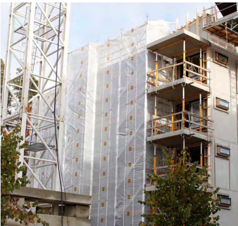
KUVA 17 Julkisivusuojaus.
