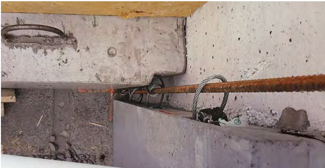
KUVA 43 Tarkastuksen kohteet ja toteutetut detaljit voidaan dokumentoida valokuvaamalla.
