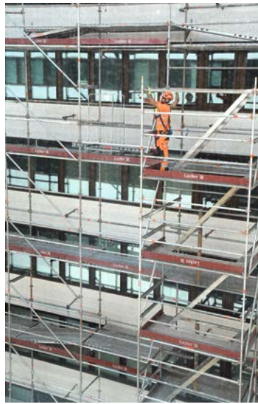
Telineiden pystytystä toimistotalon julkisivuremontissa Helsingissä.
