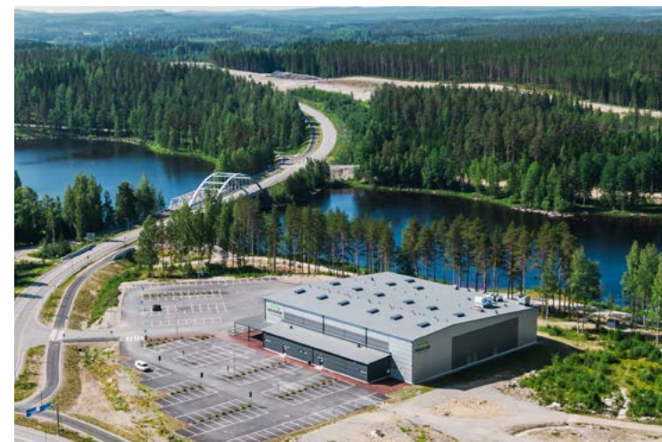
Äänekoski Arena on yksi uusimpia urheilurakennuksia liikunnallisena tulentussa kaupungissa.
